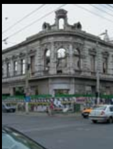
Pagina 28 București, zona protejată Buzești-Griviței. Clădiri de patrimoniu degradate
